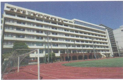
8階建校舎工事完成
